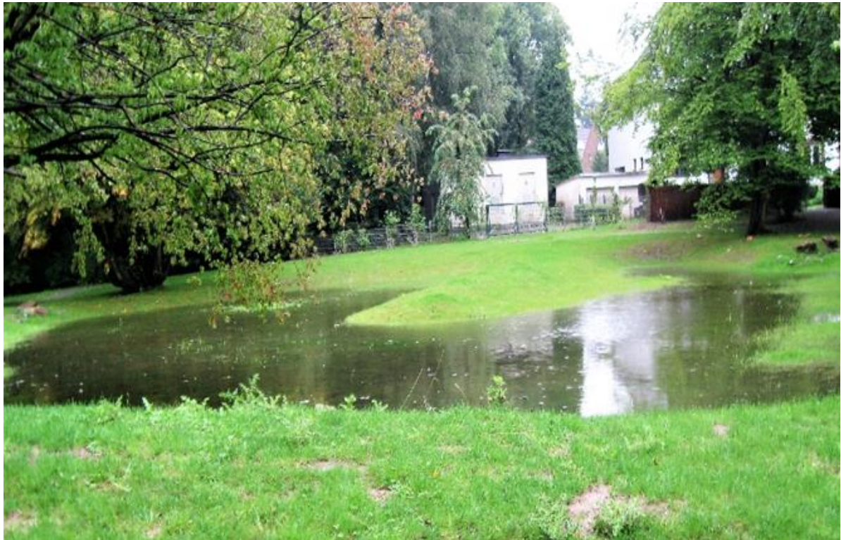
Abbildung 5-26 Temporärer Wasserrückhalt in einer Grünanlage (Foto: K.Plan)
