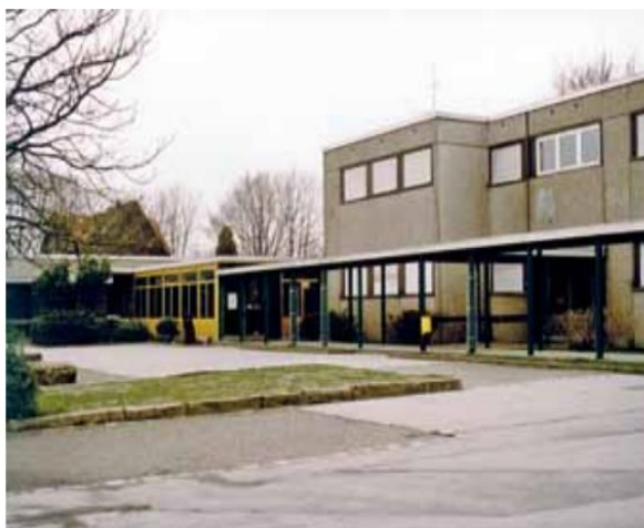
Der Schulhof der Paul-Dohrmann-Schule vor der Umgestaltung
