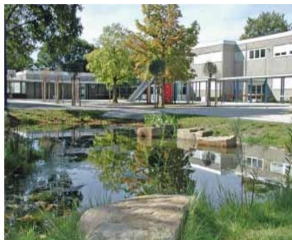
Der Schulhof der Paul-Dohrmann-Schule nach der Umgestaltung: Regenwasser wird für die Schülerinnen und Schüler erlebbar. Von den Gebäudedächern und vom Schulhof gelangt das Regenwasser über eine zentrale offene Wasserrinne in einen Teich
